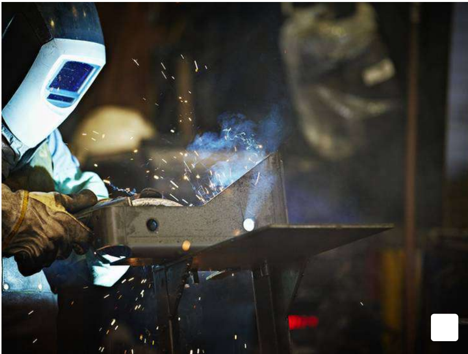
Soldador trabajando en instalaciones de fabricación de acero / Thomas M. Barwick
