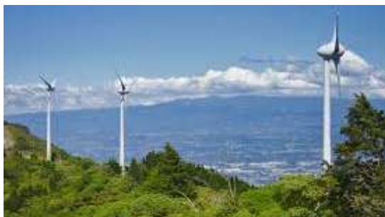
Concesión de ayudas a la inversión en la repotenciación de instalaciones eólicas, en la renovación tecnológica y medioambiental
